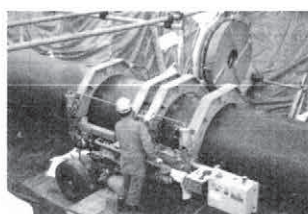
融着状況現場写真
