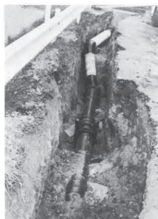
上水道配水管路
