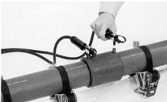
出力ケーブルの接続
