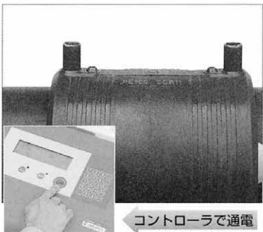
管と継手のセット・通電開始 電熱線が発熱を始め、樹脂の温度が上昇します。
