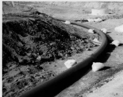
呼び径150、曲げ半径25mでの生曲げ例
