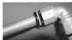
②標線が消えるまでパイプを挿入
