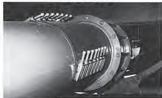
修理用クランプ設置例
