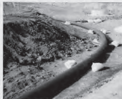
呼び径150、曲げ半径25mでの生曲げ例
