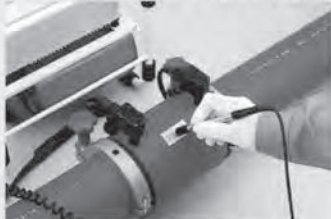
●EFソケットの施工
