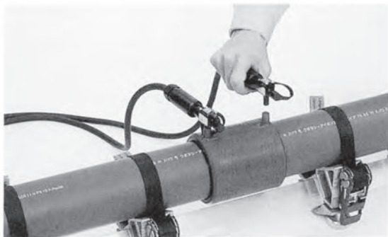
出力ケーブルの接続
