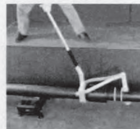
Step3 ハンドルを引いて管を 引き込み接合完了
