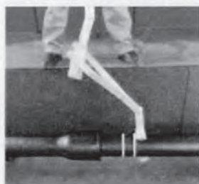
Step1 サイトコネクトを 挿し口部にセット
